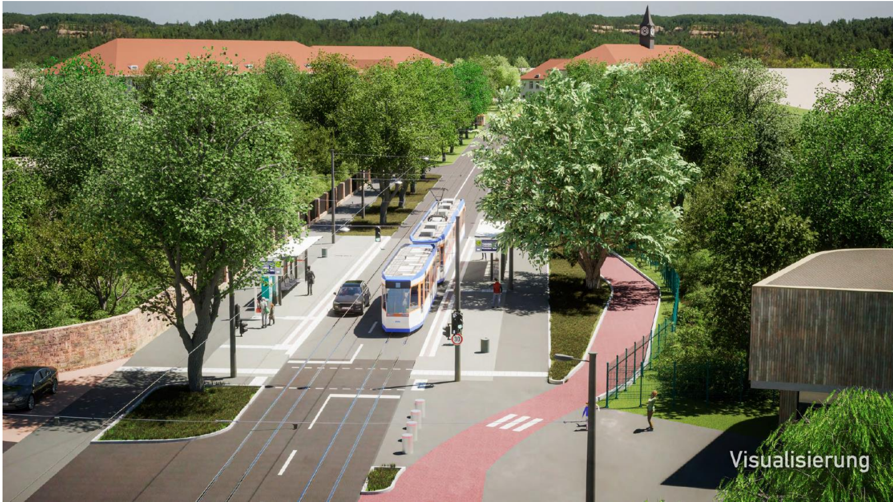
Ludwigshöhstraße mit HST Lichtenbergschule, straßenbündiger Bahnkörper
